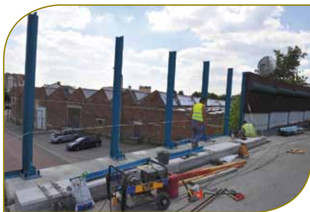
Installation d'écrans acoustiques près de Valenciennes © DIR Nord
