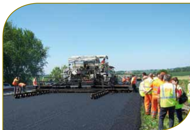
A25 - réalisation de la couche de roulement © DIR Nord
