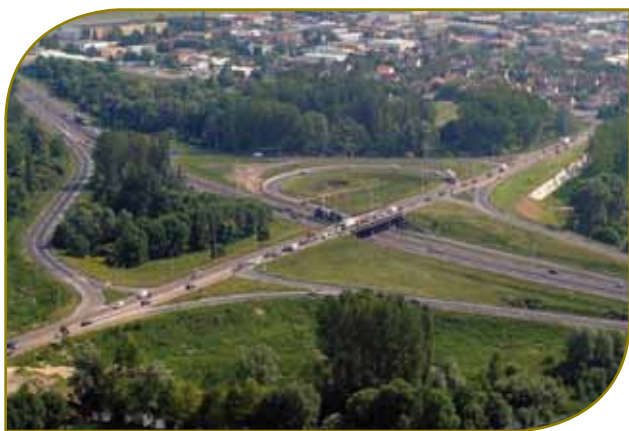
Echangeur © Préfecture du Nord - BCI
